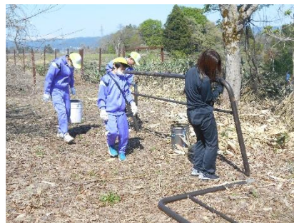
互いに力を合わせながらフェンスを設置しました。
